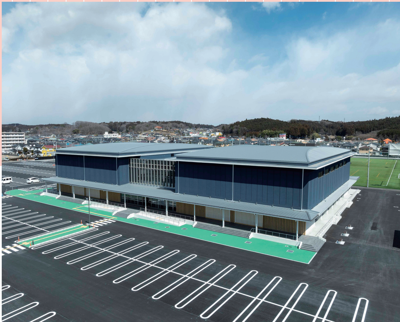
矢板市文化スポーツ複合施設（矢板市）
